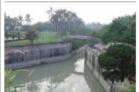
烏山頭ダムからの灌漑用水口
