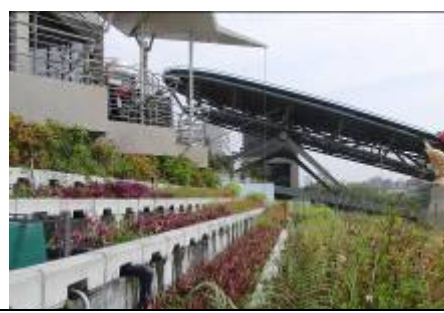
屋上を緑化して建物の温度を下げる
