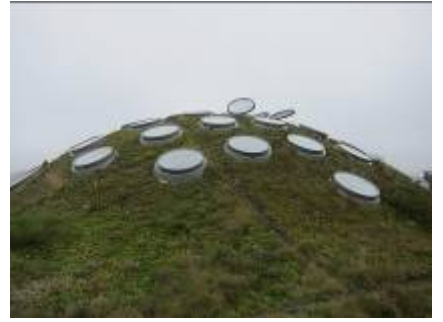
屋根の様子。窓は、光を取り入れ、170 種もの植物が植えられている、Living Roof(生きている屋根)
