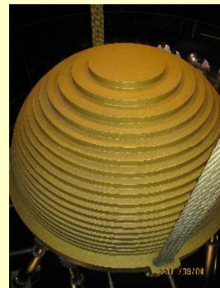
87-92 階の中央部に 660t のダンパーを下げビルの振動を押さえます。
